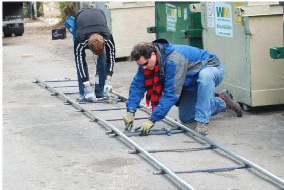
Les rails classiques sont en acier ou en aluminium, ils sont au standard 62cm, 88cm ou 100cm mais certains loueurs en proposent en 36cm d'écartement. Ils possèdent un système de raccordement male et femelle. Des tendeurs ou des grenouillères permettent l'assemblage solide de plusieurs tronçons. Ils existent en courbe. On peut utiliser ces rails en extérieur car leur rigidité permet un calage facile.
